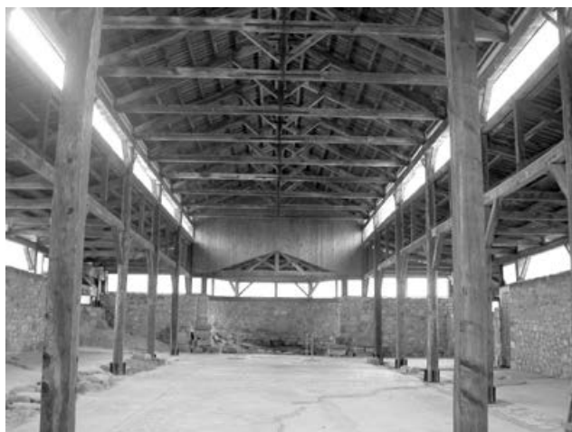
Εικ.4. Υπάρχουσα κατάσταση στο εσωτερικό.
