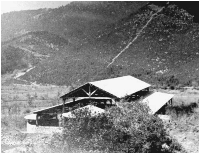
Εικ.2 Το στέγαστρο Δημακόπουλου ήταν μια ανοικτή ξύλινη κατα- σκευή. Οι πέτρι- νοι περιμετρικοί τοίχοι κτίστηκαν το 1966 επί των αρχαίων ερειπί- ων και η ξύλινη κατασκευή ολο- κληρώθηκε το 1967.
