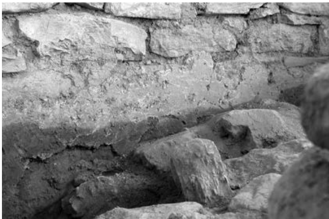
Εικ.10 Τα επιχρίσματα στον τοίχο της ανατολικής αψίδας.
