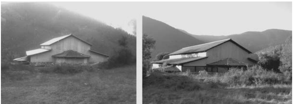
Εικ.3. Μετά την κατασκευή του το στέγαστρο Δημακόπουλου κλείστηκε με φύλλα αμιαντοτσιμέντου (φωτο αριστερά, αρχείο ΔΒΜΑ, 1971). Αργότερα ανοίχθηκαν δυο σειρές σταθερών παραθύρων (φωτό δεξιά, σημερινή κατάσταση).
